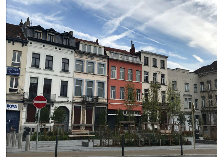
Rénovation de la Place Masui
