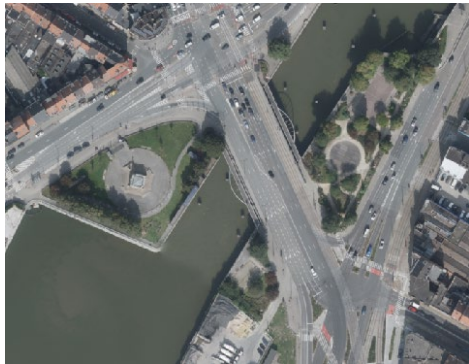
Les places publiques autour du Pont De Trooz (google)
