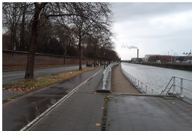
Le quai abaissé pour piétons (Ch. De Vilvorde)
