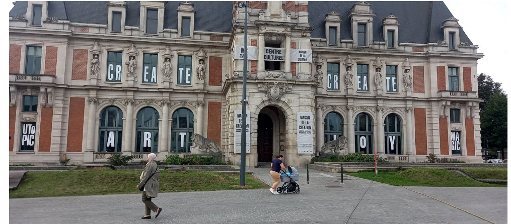
Rénovation de la Place Bockstael
