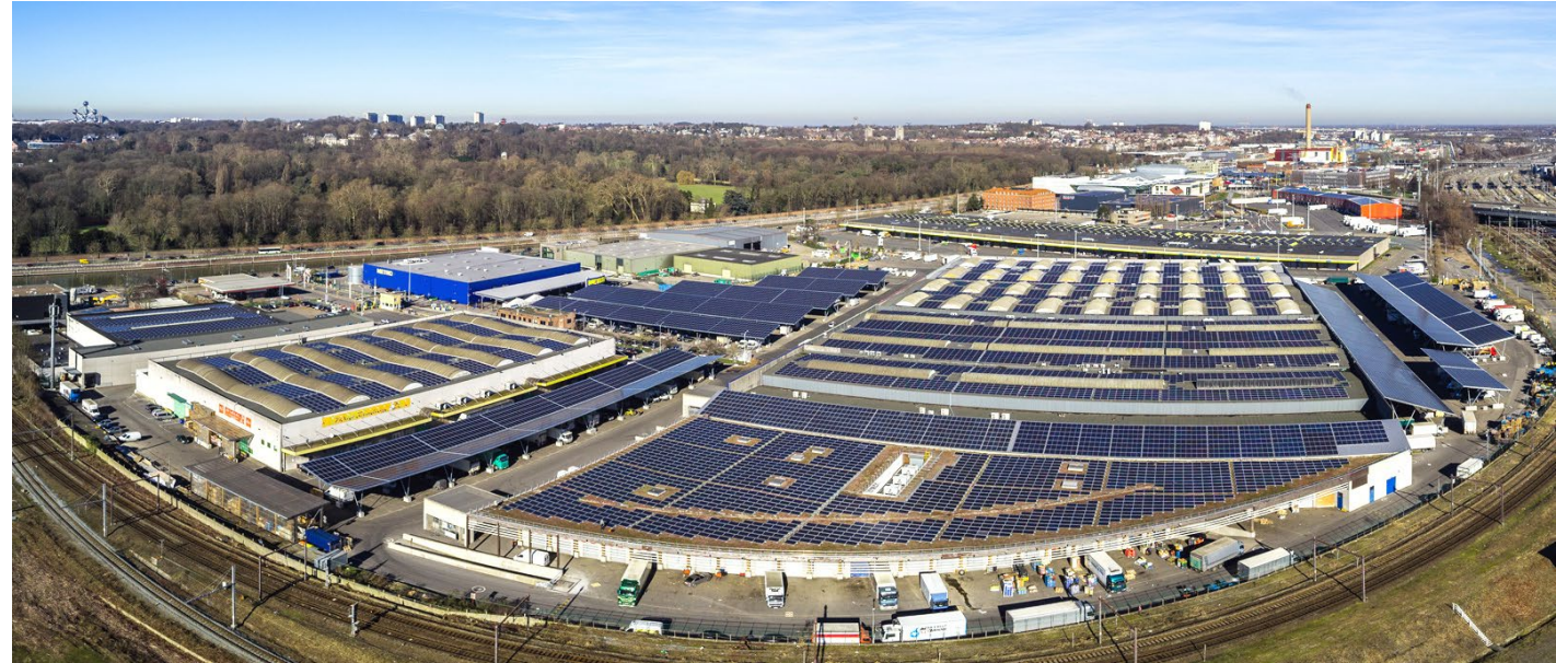
Source: Inauguration du premier parking solaire de Belgique - Mabru
