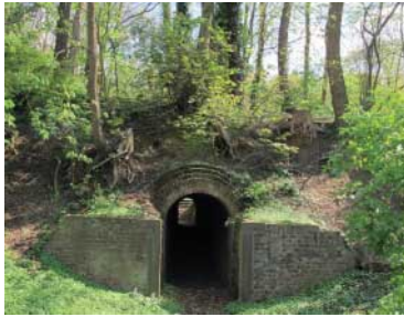
↑ Tunnel et tranchée du tir national
