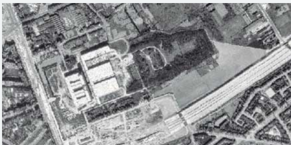
Photo aérienne de l'installation des sièges télévision et construction de l'E 40 : 1970.
