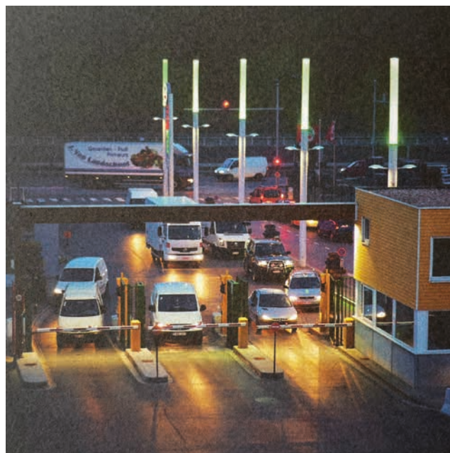
↑ Portail d'entrée du MaBru, Bruxelles, BE
