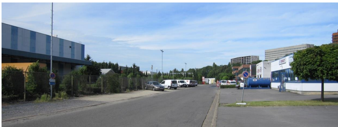
Figure 56 : Vue de la zone d'industrie urbaine et de la voirie traversant le site (ARIES, 2015)
