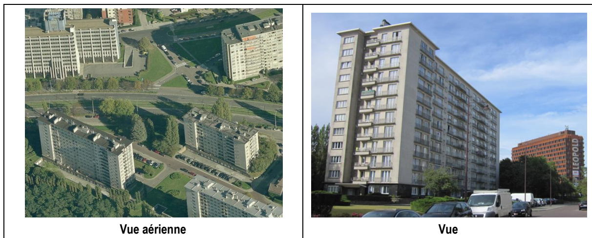
Figure 39 : Barres d'appartements et de bureaux à l'est (Bingmaps et ARIES, 2015)
