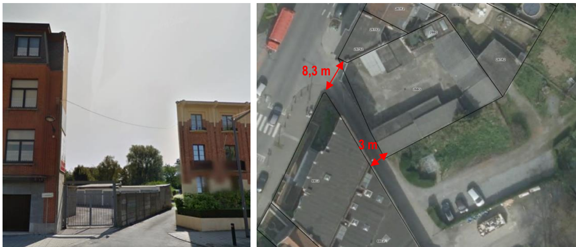
Figure 192 : Points de passage depuis l'ouest vers le site du côté ouest : au centre (à gauche) et au nord (à droite) (Google street view, 2013)
