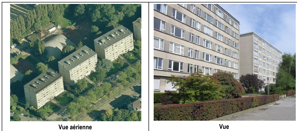
Figure 38 : Immeubles d'appartements au sud (Bingmaps et ARIES, 2015)
