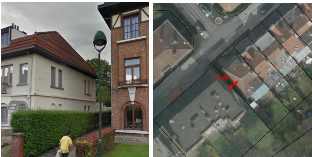
Figure 191 : Points de passage au centre vers le site du côté ouest : vue et parcellaire (Google street view 2013, cadastre et orthophotoplan Brugis 2014)
