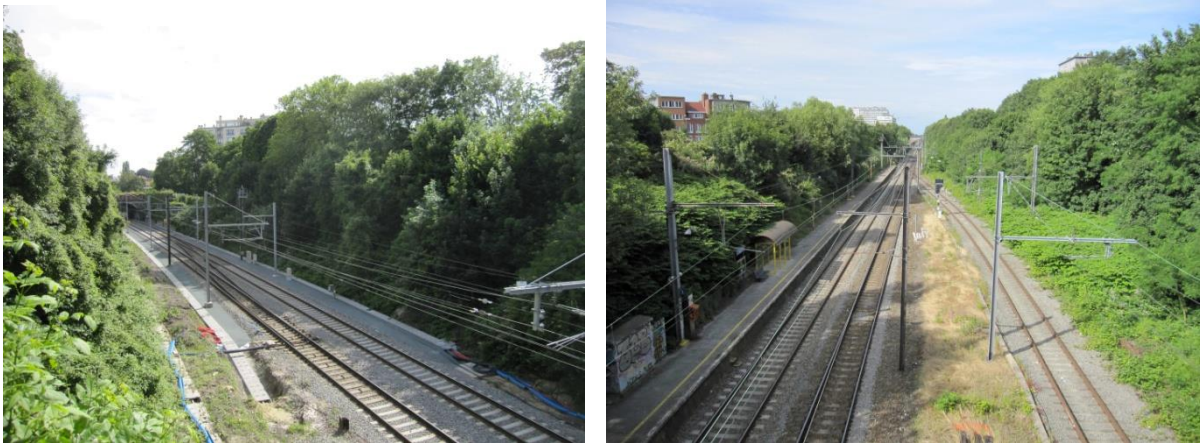
Figure 44 : Vue des voies ferrées au sud du site (à gauche) et au nord du site (à droite) (ARIES, 2015)
