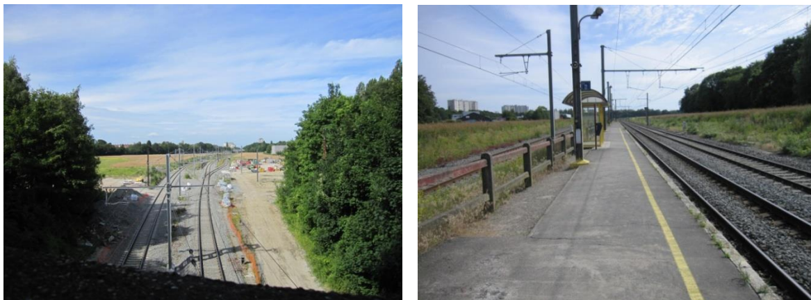
Figure 57 : Vue des voies ferrées au sud de la zone (à gauche) et des quais de la gare d'Evere (à droite) (ARIES, 2015)
