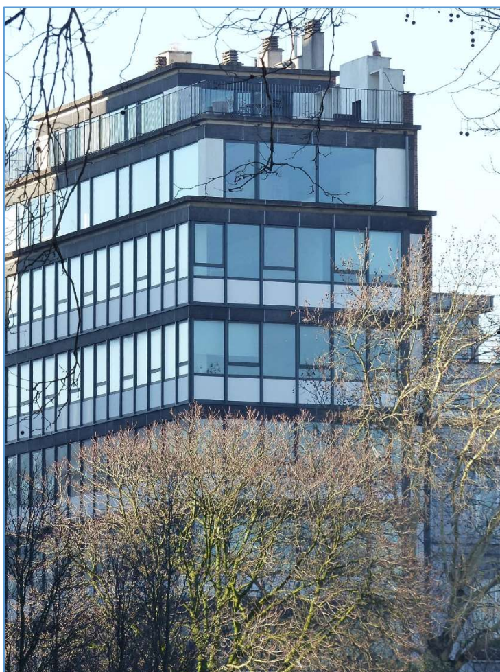
Louizalaan 461 (arch. A.J. De Donker): kantoorgebouw, gedeeltelijk omgebouwd tot woningen.
