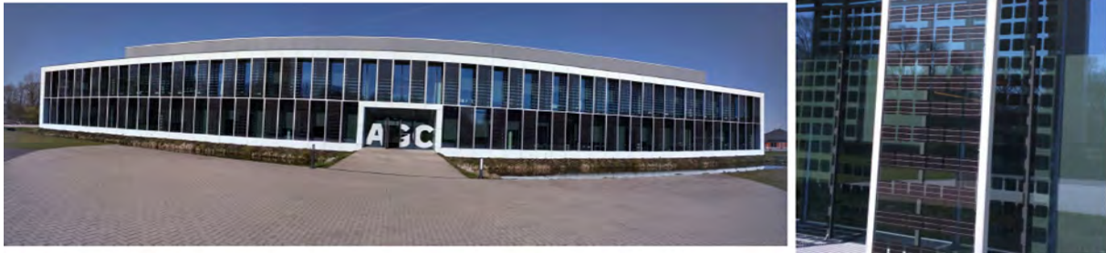
Figuur 512: In de gevels geïntegreerde fotovoltaïsche panelen (BIPV) (Voorbeelden Archiexpo.fr)
