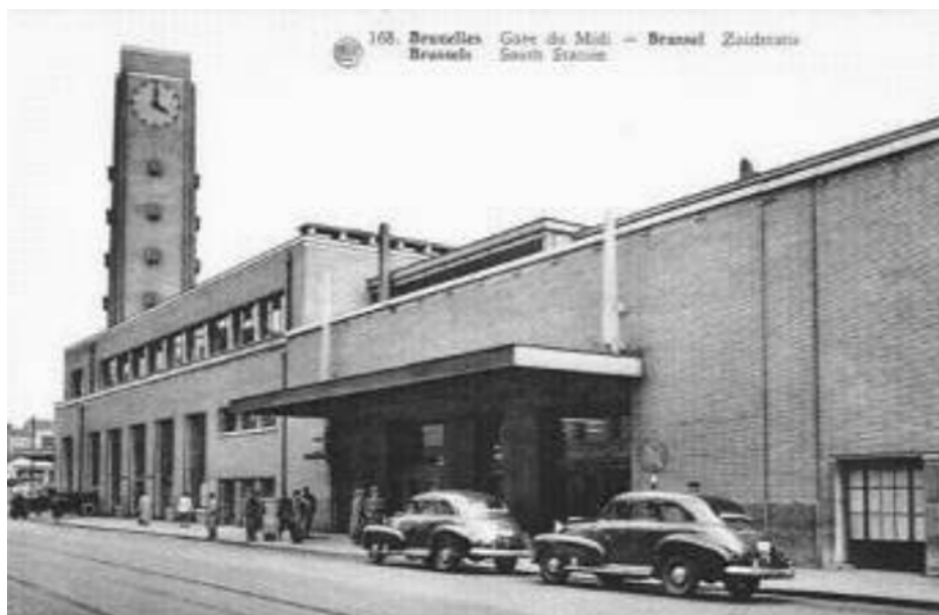
Figuur 5: Zicht op de hoofdingang van het 3 de Zuidstation (Reflexcity)
