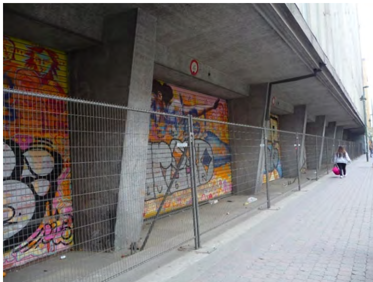
Figuur 228: Leegstaand gebouw aan de Fonsnylaan (ARIES, 2018)
