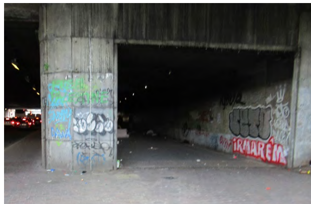
Figuur 230: Tunnel met een kamp van daklozen (ARIES, 2018)
