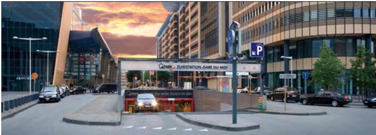
Figuur 163: Toegang parking Q-Park langs de kant van de E. Blérotstraat
