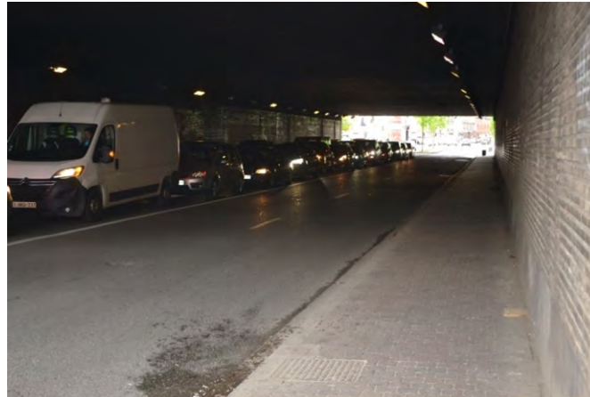
Figuur 229: Oversteekplaats ter hoogte van de Veeartsenstraat (ARIES, 2018)
