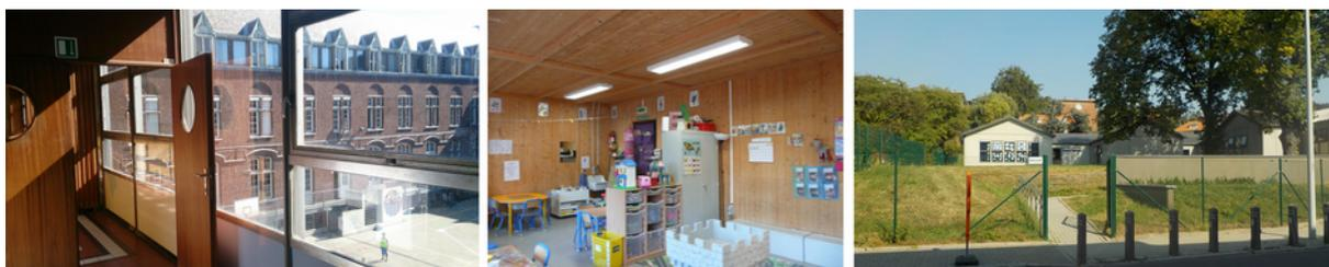
*De gauche à droite : porte d'évacuation fermée à clé, sortie de secours encombrée, site non accessible au camion de pompiers*
