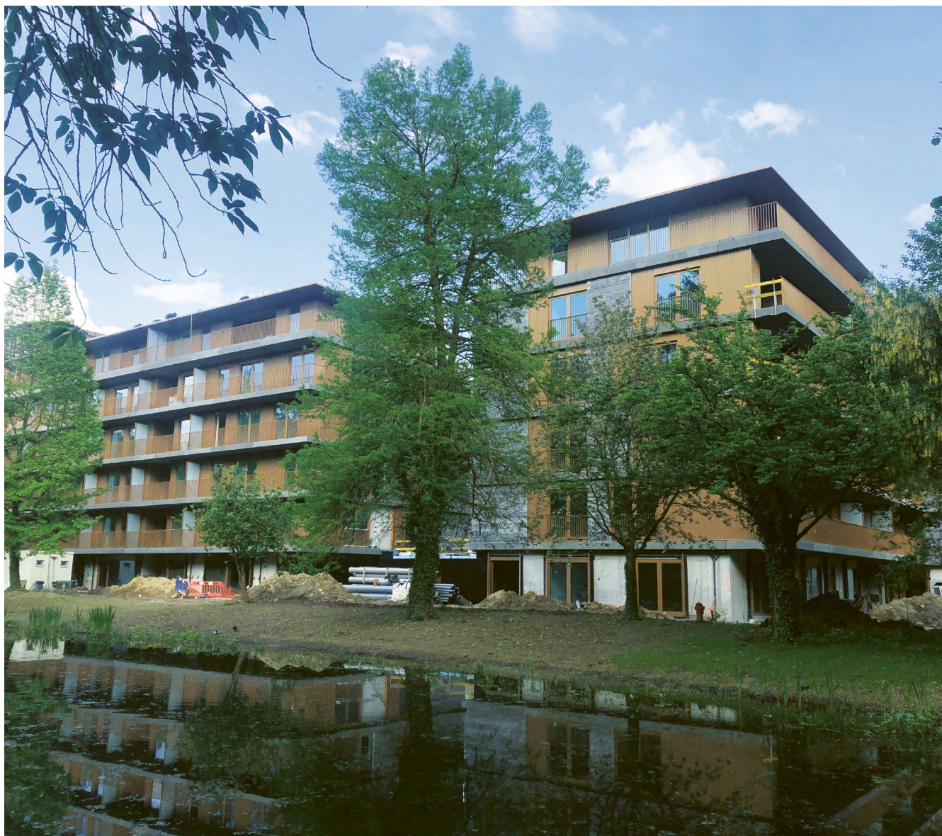
↑ Photo 12 Construction de logement sur un ancien site de bureau en zone administrative, boulevard du Souverain, Watermael-Boitsfort (mai 2024)
