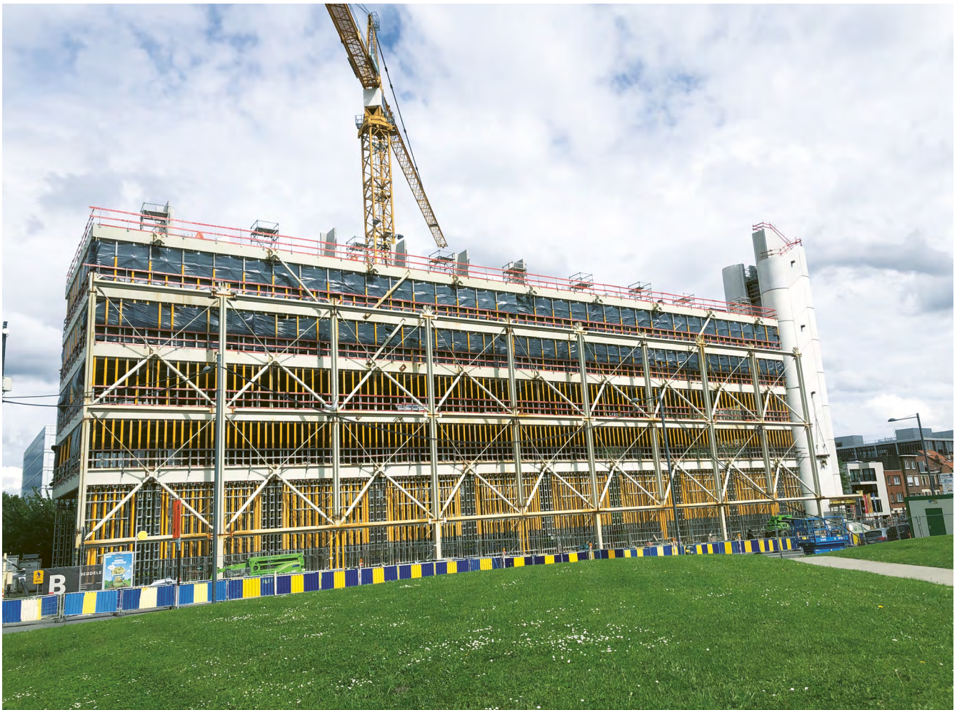
↑ Photo 3 Construction du Frame de Mediapark.brussels, boulevard Auguste Reyers, Schaerbeek (mai 2024)
