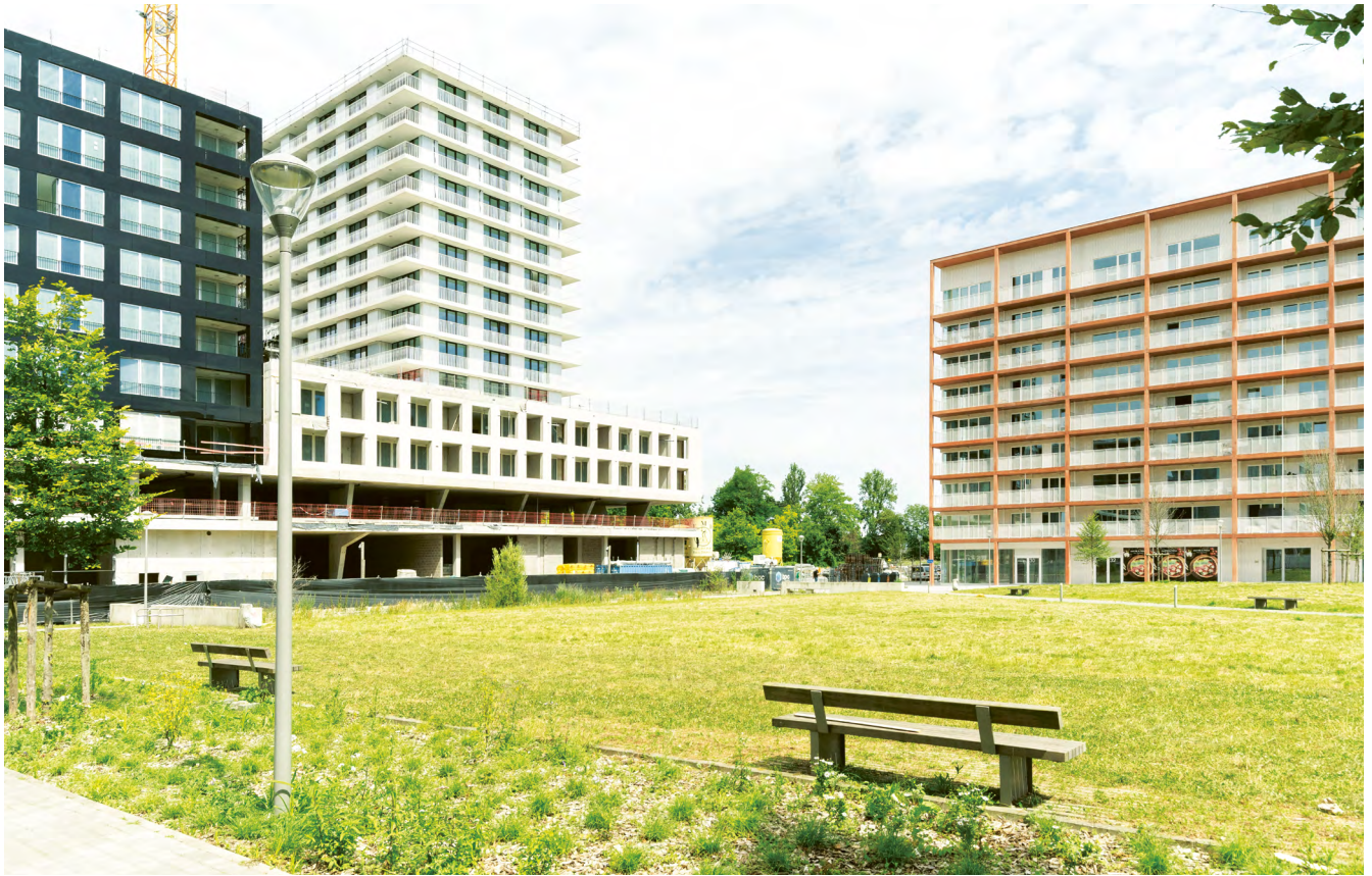
↑ Photo 2 Création de logements rue de la Manufacture, Anderlecht (juillet 2024)
