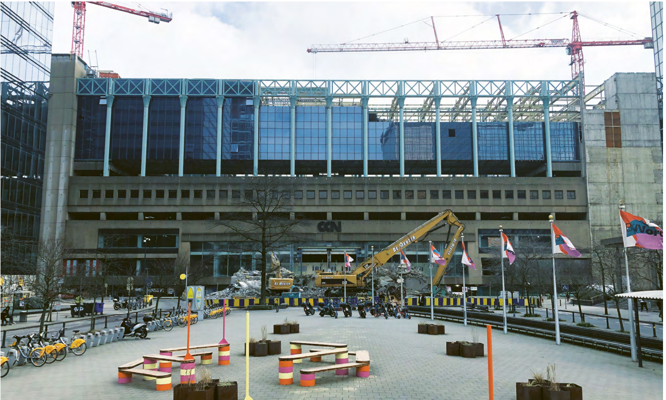
↑ Photo 5 Destruction du CCN, Gare du Nord, Bruxelles (mars 2024) Foto 5 Afbraak van het CCN, Noordstation, Brussel (maart 2024)
