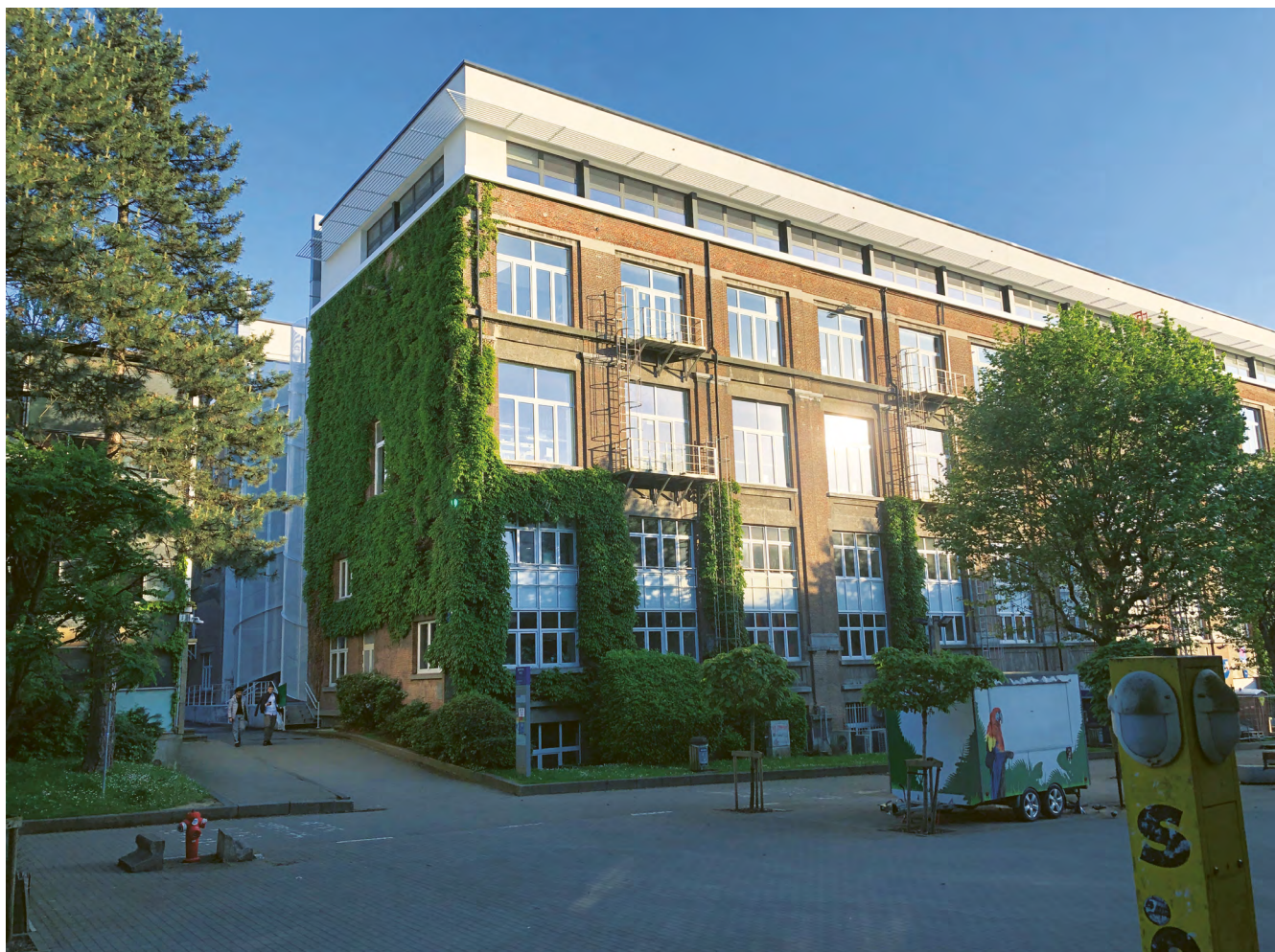
↑ Photo 13 Ajout d'un étage supplémentaire dans un bâtiment de l'ULB sur le campus du Solbosch, Ixelles (mai 2024) Foto 13 Toevoeging van een extra verdieping op een gebouw van de ULB op de Solboschcampus, Elsene (mei 2024)
