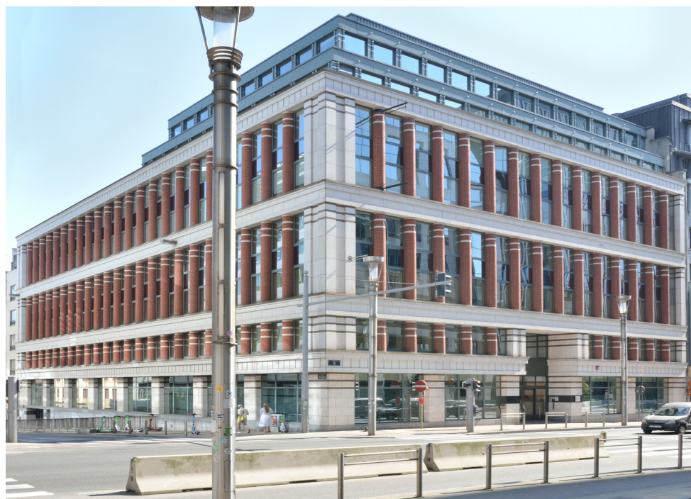
↑ Photo 6 : 62 rue de la Loi © 51N4E-Greich
