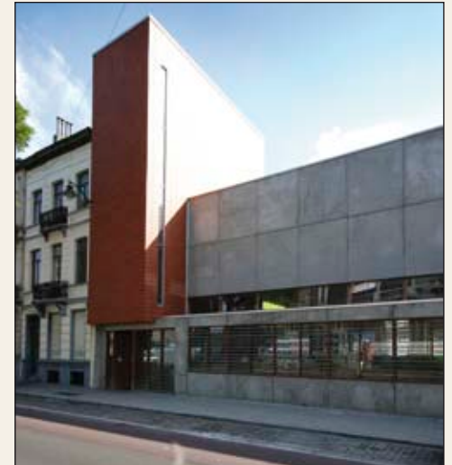
Hall des sports Van Volxem , Avenue Van Volxem, Forest, Objectif 2, 2006. Architectes: Jean-Philippe Caufriz, Bureau d'architectes Nicolas Gouygou.
