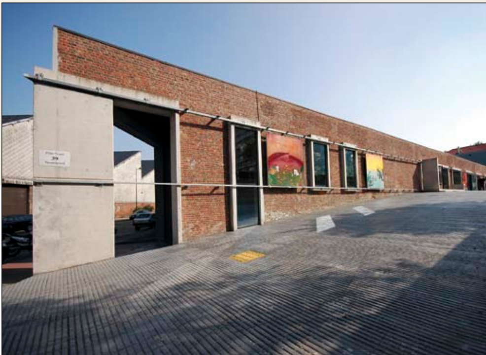
Centre sportif et culturel Pôle Nord , Chaussée d'Anvers, Ville de Bruxelles, Contrat de quartier Nord et Objectif 2, 2005. Architecte: Bureau d'engineering et d'architecture industrielle.
