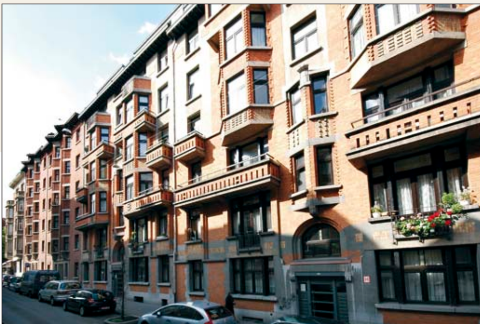
Logements sociaux, Rue Combaz, Saint Gilles, Foyer Saint-Gillois, SLRB, 2000.
