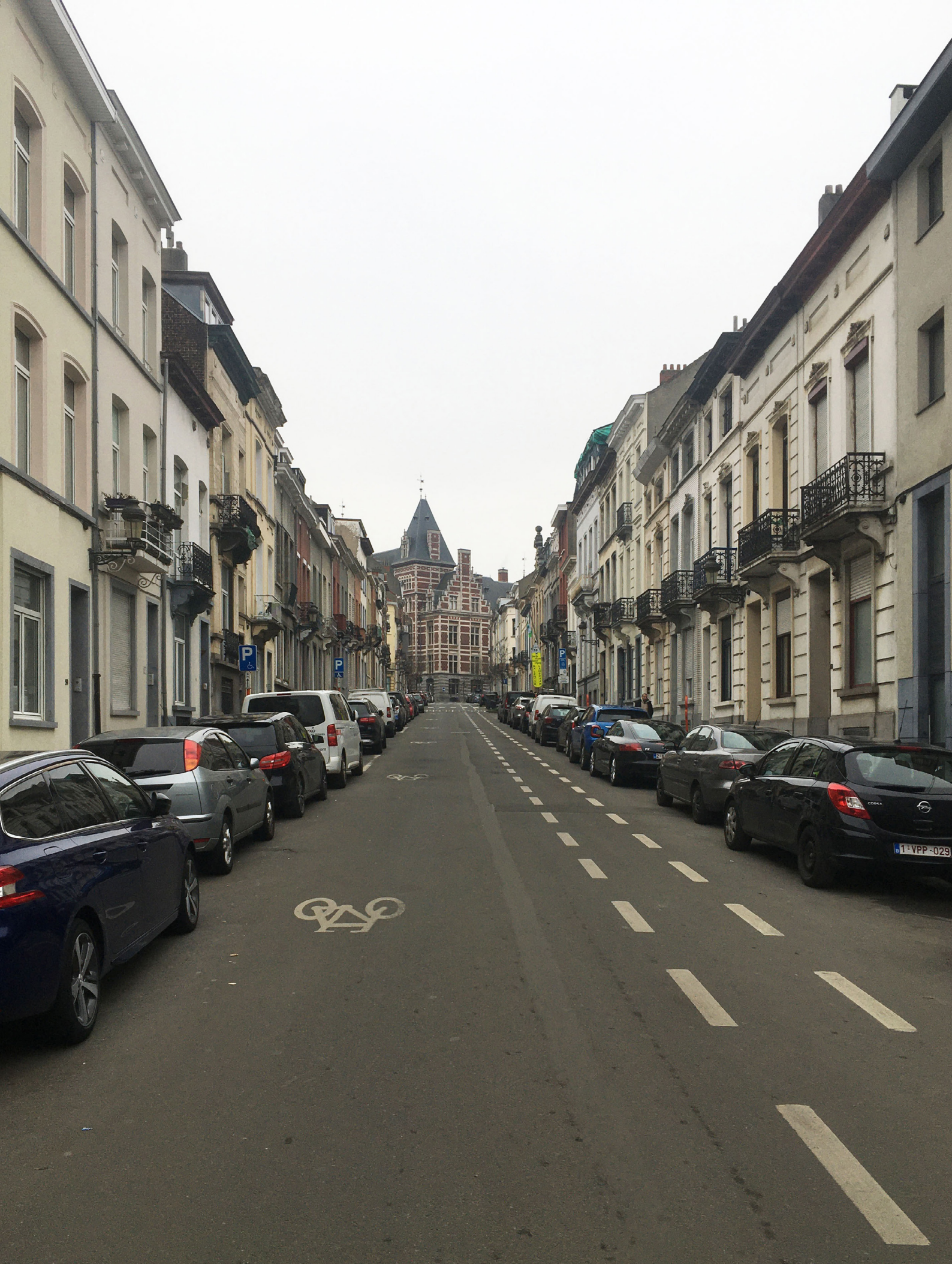
→ Vue de la rue Quinaux vers la Maison communale de Schaerbeek
