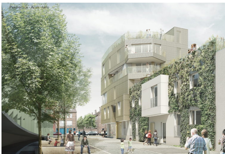
Project voor duurzame woningen, Vandermaelenstraat (foto: citydev. brussels)
