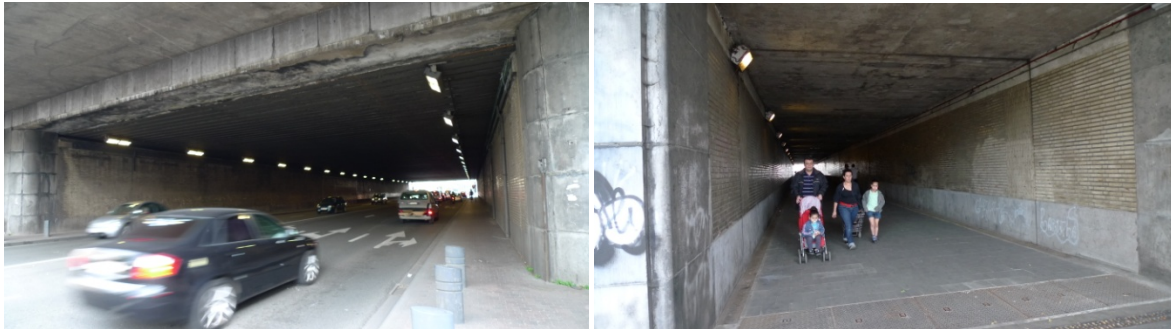
Illustratie 43: Tunnel van de Veeartsenstraat, gedeelte voor auto's en gedeelte voor voetgangers
