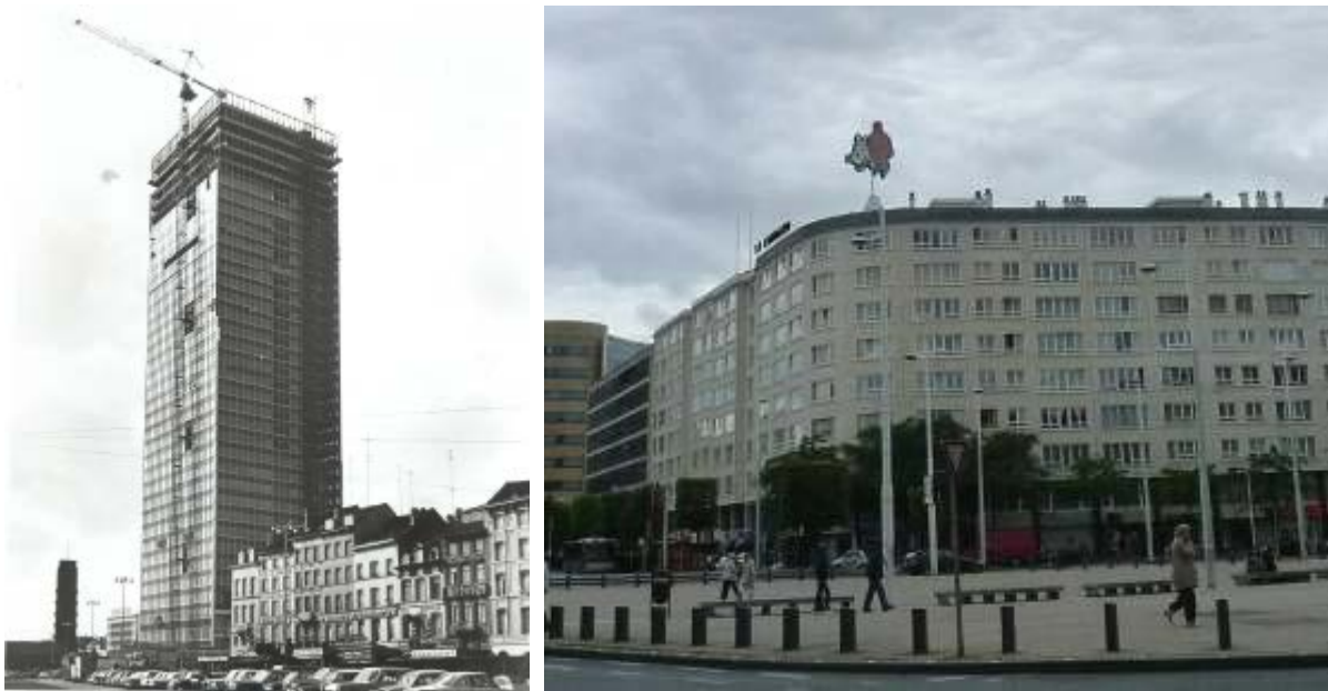
Illustratie 9: Links: De bouw van de Zuidtoren (1961), architecten: R. Aerts, P. Ramon, Y. Blomme, J.F. Petit, A. Bressers, A. Van Acker, M. Lambrichs, J. Van Dooselaere. Rechts: Zicht op het gebouw op de hoek van de Spaaklaan en het Baraplein
