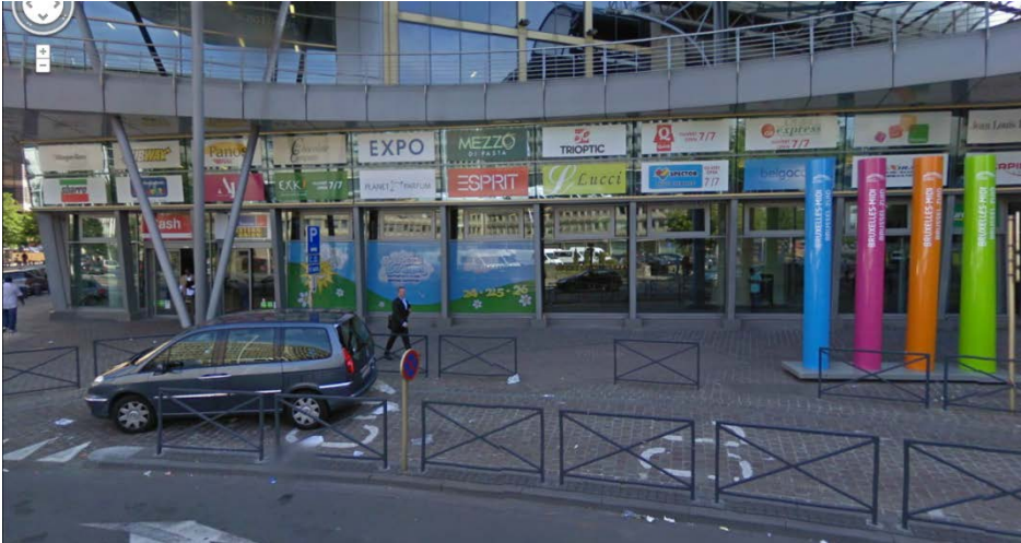
Illustratie 82: 'CD'-plaatsen en aangrenzende stationshal
