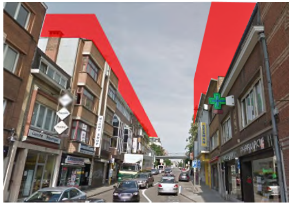
Figure 856 : Chaussée de Wavre de 12 m de large bordée de gabarits R+4 en rouge (ARIES sur fond Google Street View, 2018)
