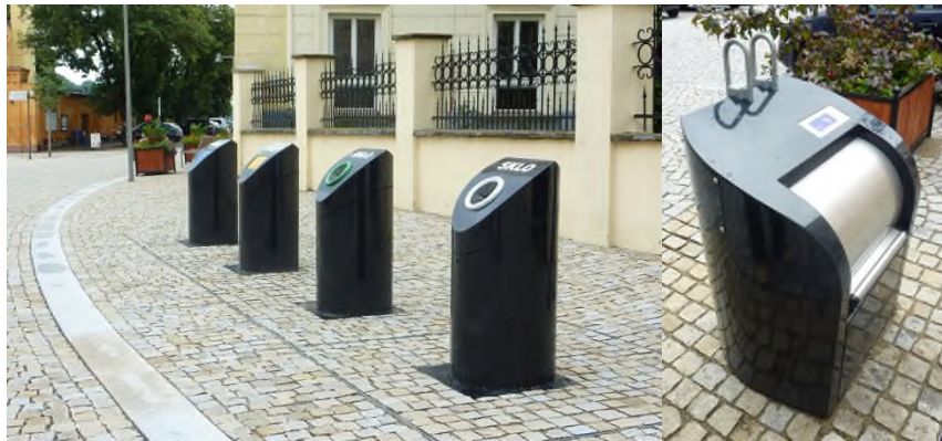
Figure 711 : Containers enterrés (société commerciale inconnue, 2015)
