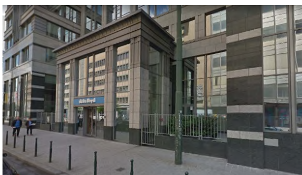
Figure 860 : Vue du renforcement d'un bâtiment avenue Fonsny à Bruxelles (Google Street View, 2018)
