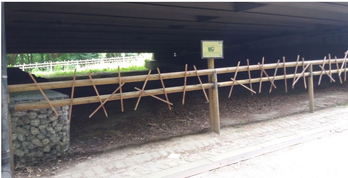
Figure 930 : Vue du passage à faune existant sous le viaduc des Trois Fontaines (ARIES, 2018)
