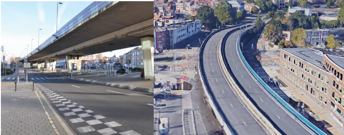
Figure 623 : Viaduc en situation existante (ORG 2 ,2019 ; Google Maps, 2019)
