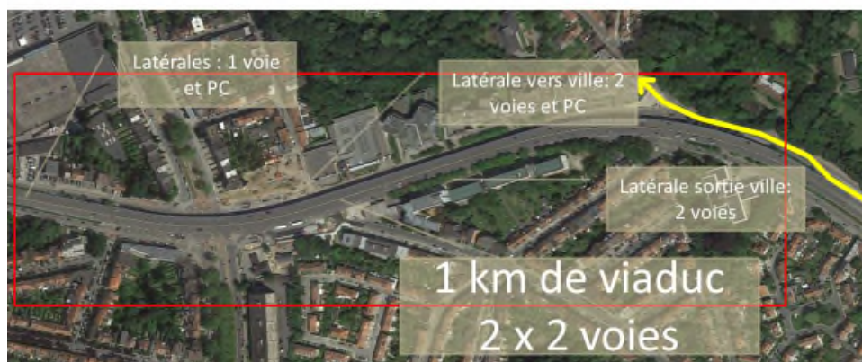
Figure 209 : Illustration du tronçon Herrmann-Debroux (Google Maps, 2018)
