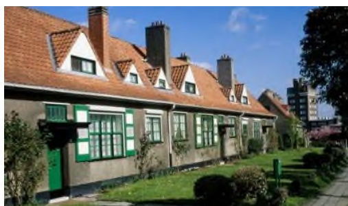
Figure 184: Cité jardin du Logis (Inventaire du patrimoine architectural de la Région de Bruxelles-Capitale - Iris monument, 2016)
