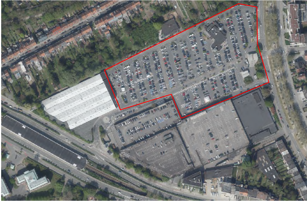
Figure 613 : Site Redevco considéré comme alternative de localisation (ARIES sur fond Brugis, 2018)
