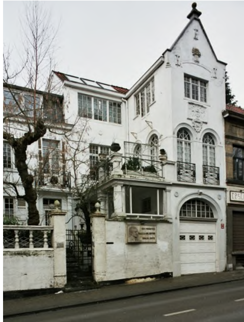
Figure 449 : Maison personnelle et atelier du peintre Oleffe (Brugis)
