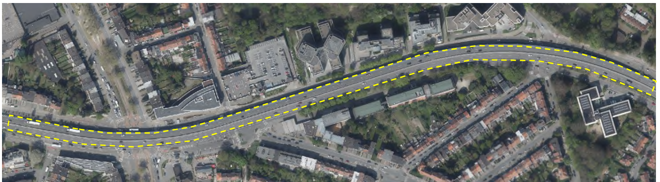
Figure 302 : Localisation du viaduc Herrmann-Debroux (Brugis, 2018)
