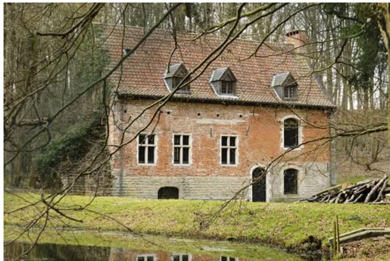
Figure 464 : Château forestier des Trois Fontaines (Brugis)
