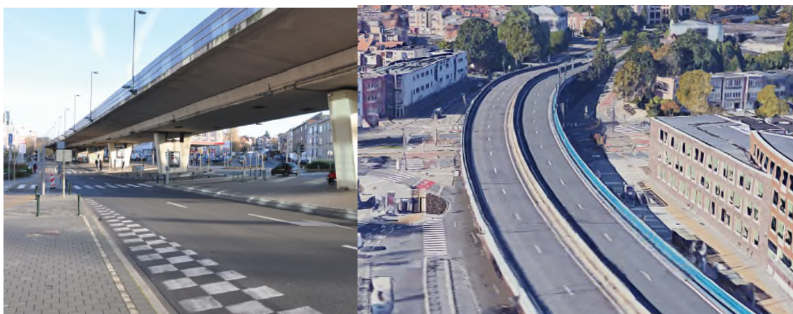
Figure 623 : Viaduc en situation existante (ORG 2 ,2019 ; Google Maps, 2019)
