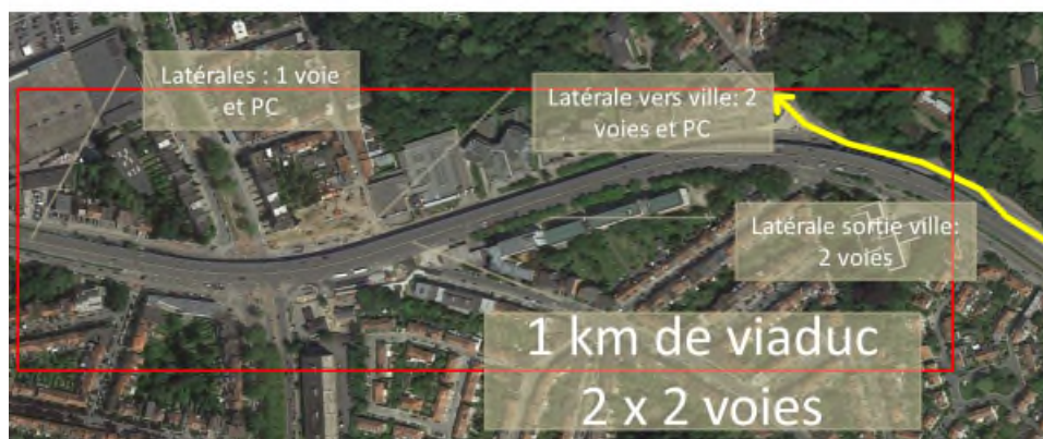
Figure 209 : Illustration du tronçon Herrmann-Debroux (Google Maps, 2018)
