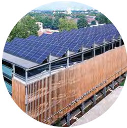
Heropwaardering daken, Freiburg im Breisgau
