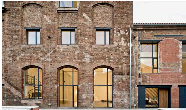
Voorbeeld van de rehabilitatie van een voormalige fabriek (Jordi Garcés, Barcelona, ES)
