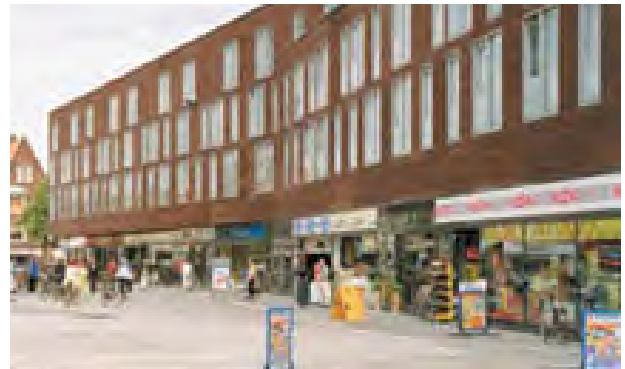
Activering van de benedenverdieping (S333, Groningen, NL)
