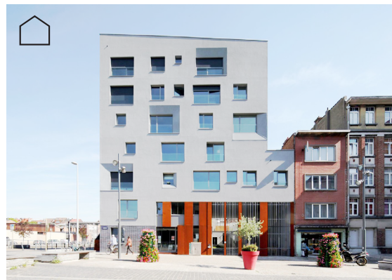
Projet mixte rue de Liverpool (photo ©B612associates)
