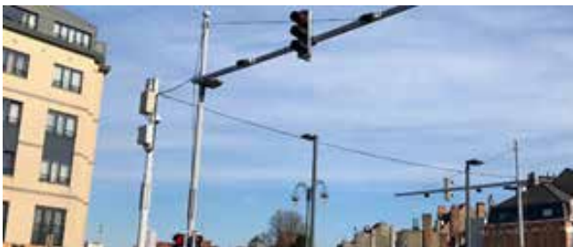
Bron: ANPR-camera's gemonteerd op de paal van een verkeerslicht in Koekelberg
