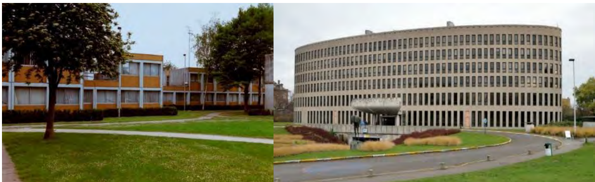
Figuur 23: Paviljoenconstructies (links) en het rectoraat van de VUB (rechts) (Irismonument, 2006 en 2014)
