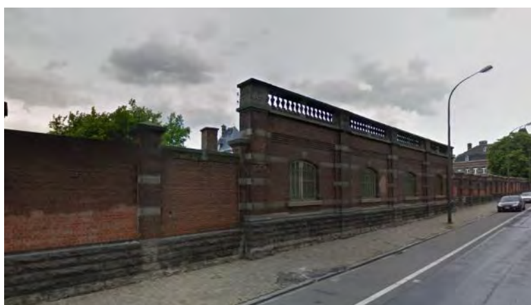
Figuur 34: Aanblik van de ommuring ter hoogte van de J. Wytsmanstraat (Google Streetview, 2014)
