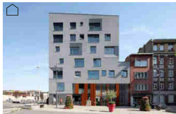
↑ Projet mixte rue de Liverpool (photo ©B612associates)
