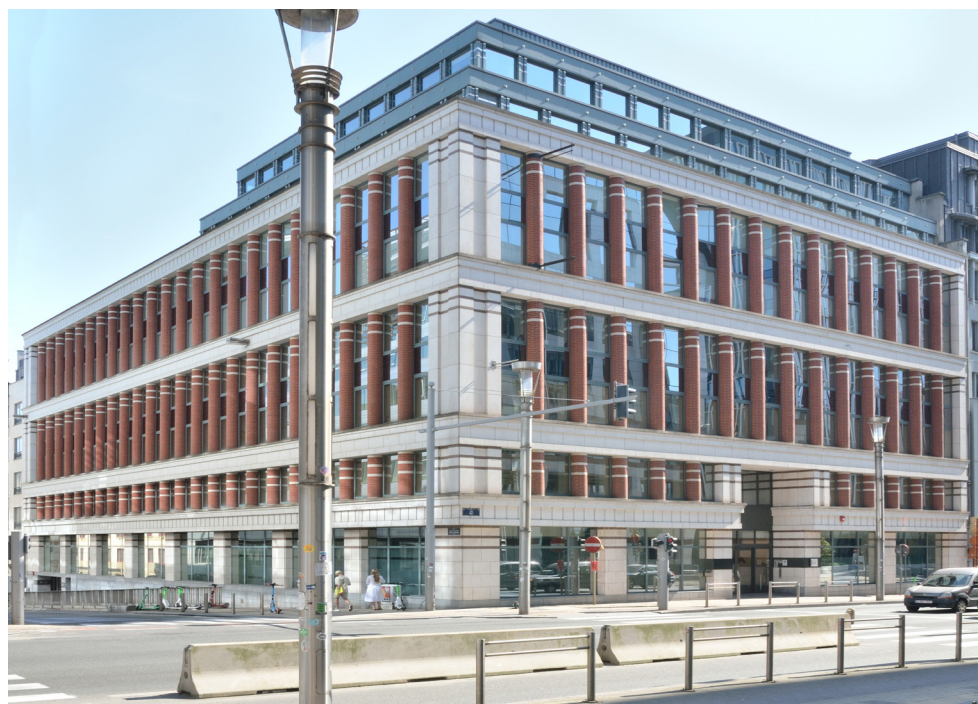
↑ Photo 6 : 62 rue de la Loi © 51N4E-Greich
